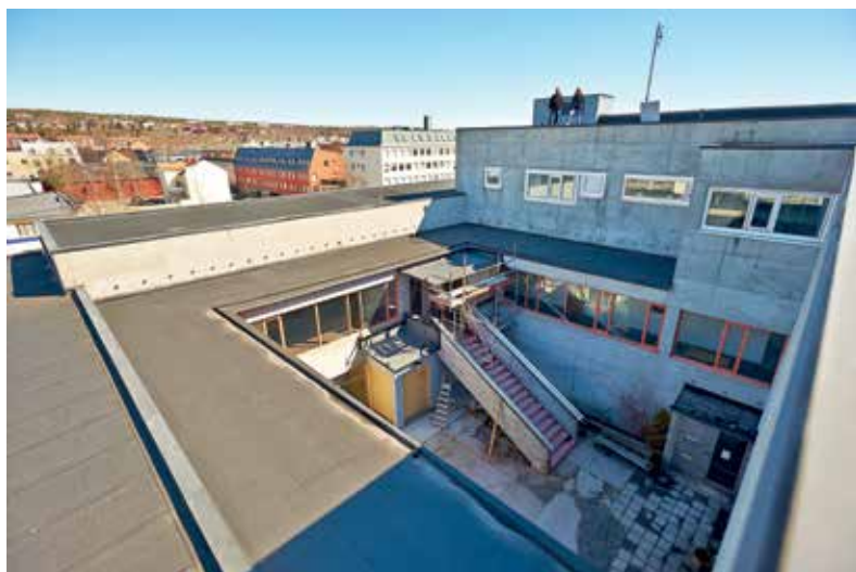
När sprängningsarbetena i innergården (atriumet) utfördes, fanns det samtidigt hyresgäster i Tingshuset.
