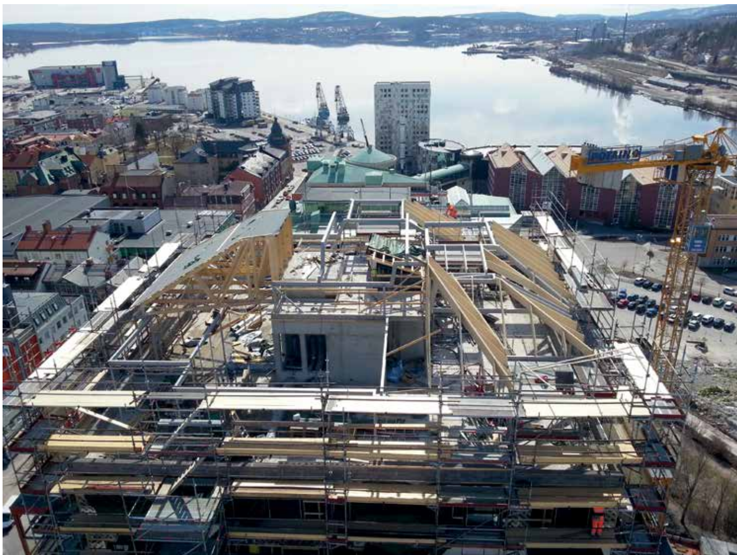
Bygget sett uppifrån. Montering av yttertak på våning 13.
