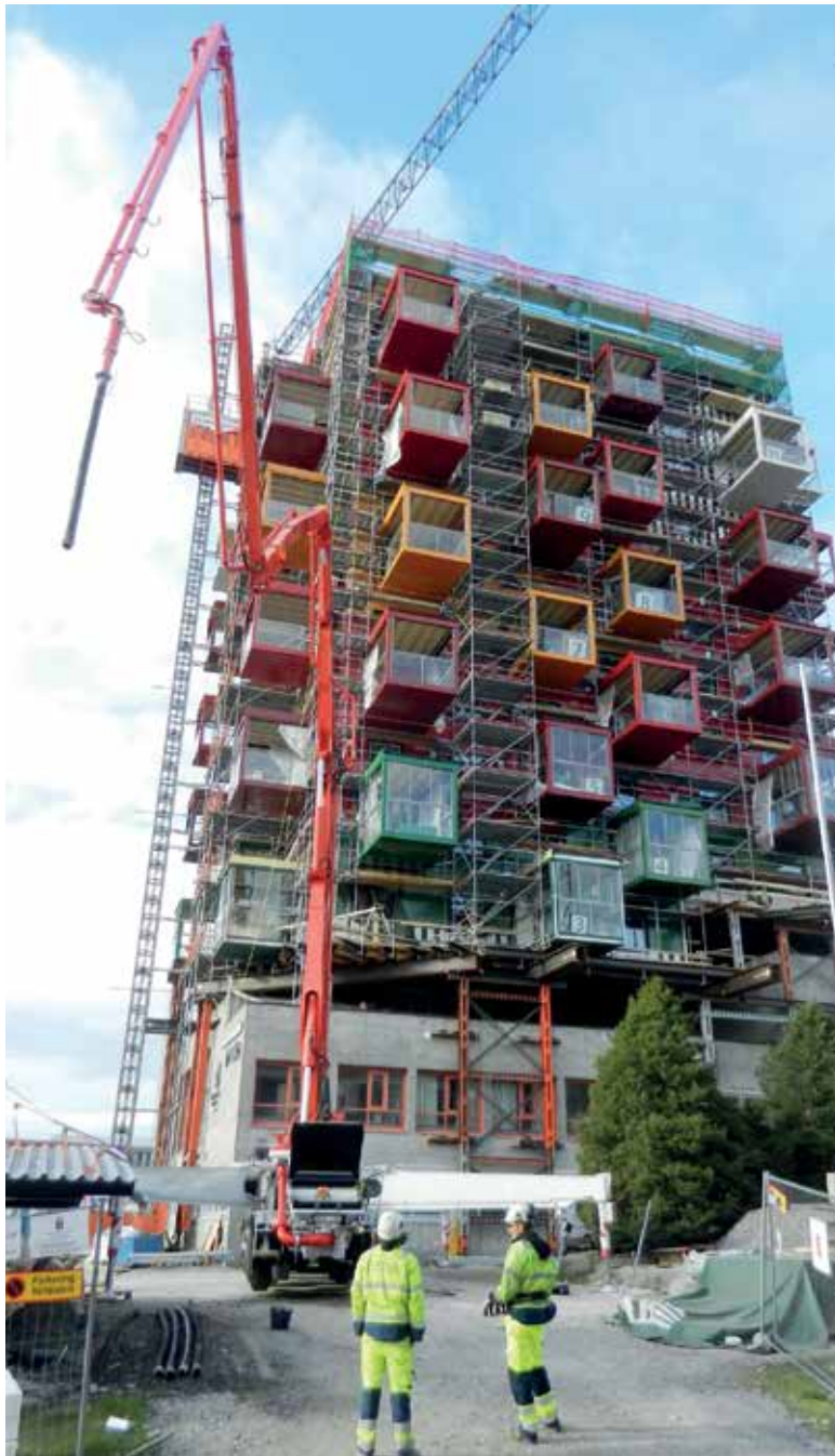
För att nå upp till översta våningen använde man sig av Nordens största betongpump som är 56 meter hög och alldeles ny.
