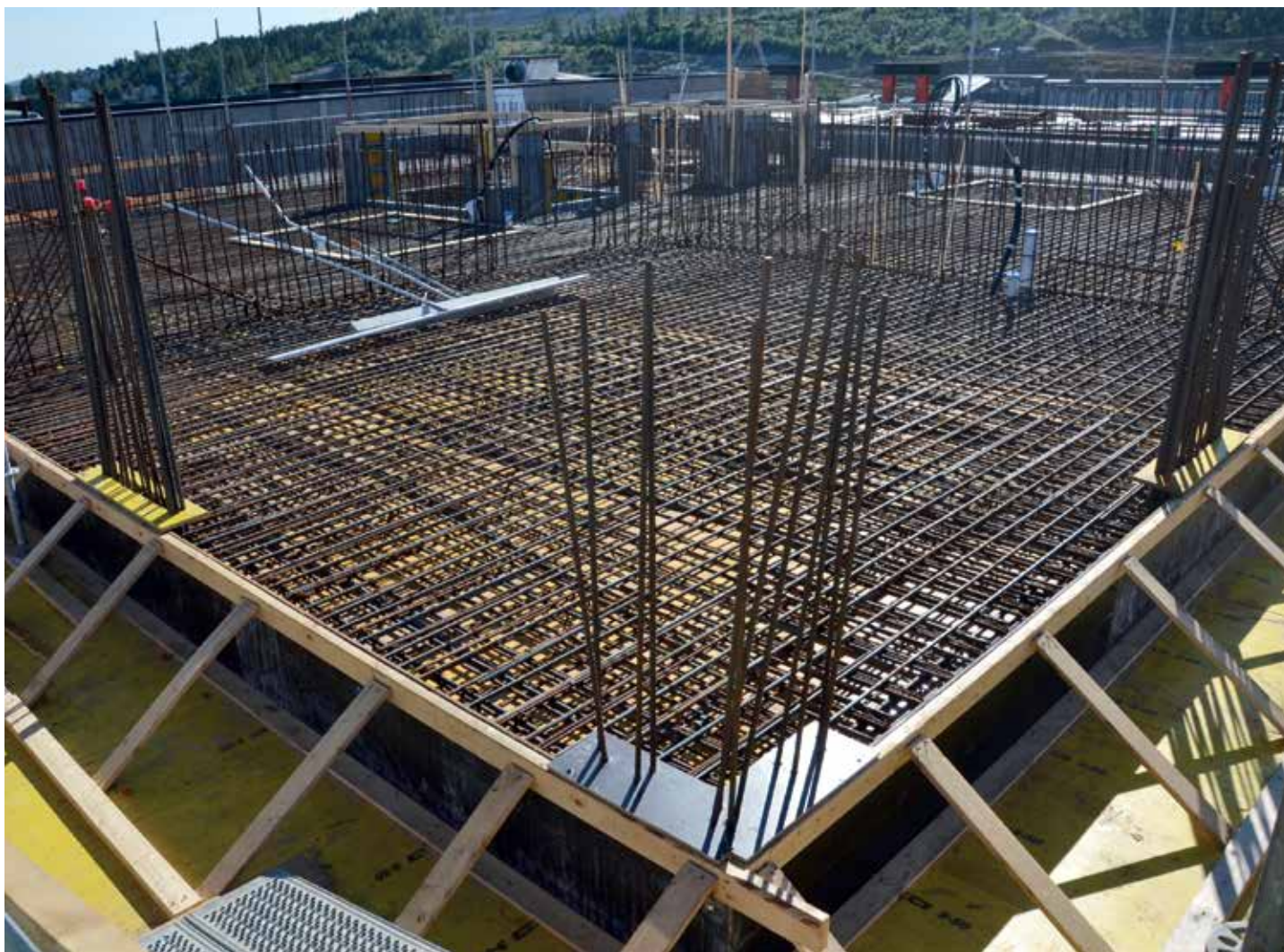
De flesta armeringsjärnen är av en grövre modell som annars används i brobyggen.
