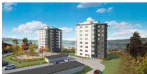
Totalt 34 lägenheter ska byggas i den höga höghuset som kallas Solsidan.
